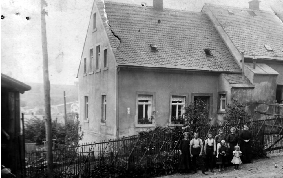
Wohnhaus Gräßler in Geyer am Ziegelsberg
